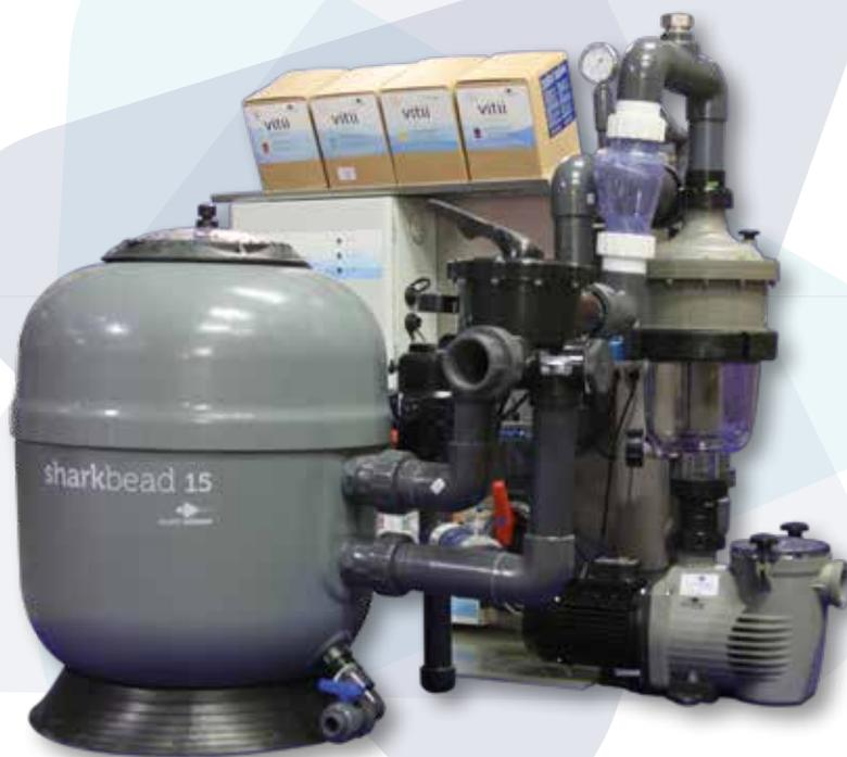
Placer la pompe en-dessous du niveau d'eau afin de limiter les pertes de charge et préserver cet outil.
