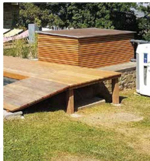
*Un bel exemple de bio-rénovation d'une baignade naturelle : la « zone de régénération » est remplacée par une plage en pierre bleue et la nouvelle filtration biologique est installée dans un élégant local technique en bois.*
